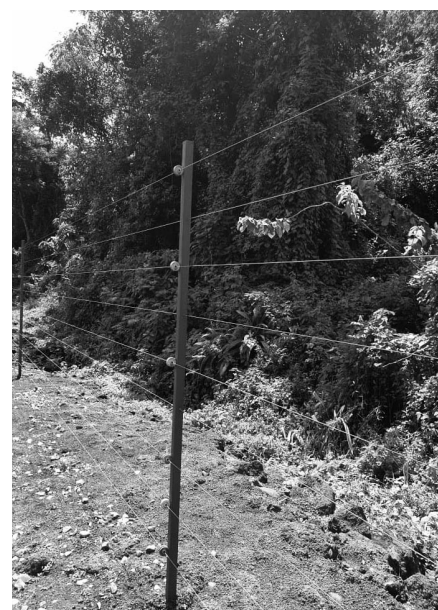
Gros plan sur la clôture électrique
