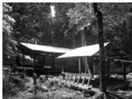
Nouvelles constructions au camp de gardes de Afi Photo: Ubi Sam
